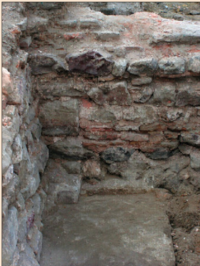
Іл. 13. Ділянка ремонту XII ст. південно-західного кута Десятинної церкви. Фото А.А. Чекановського. 2005 р.
