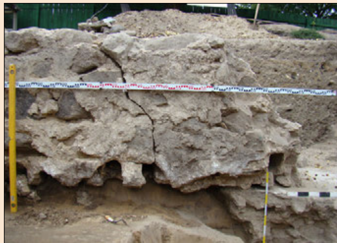
Іл. 10. Пісковик у кладці фундаменту західної стіни Десятинної церкви. Фото Ю.В. Лукомського. 2009 р.
