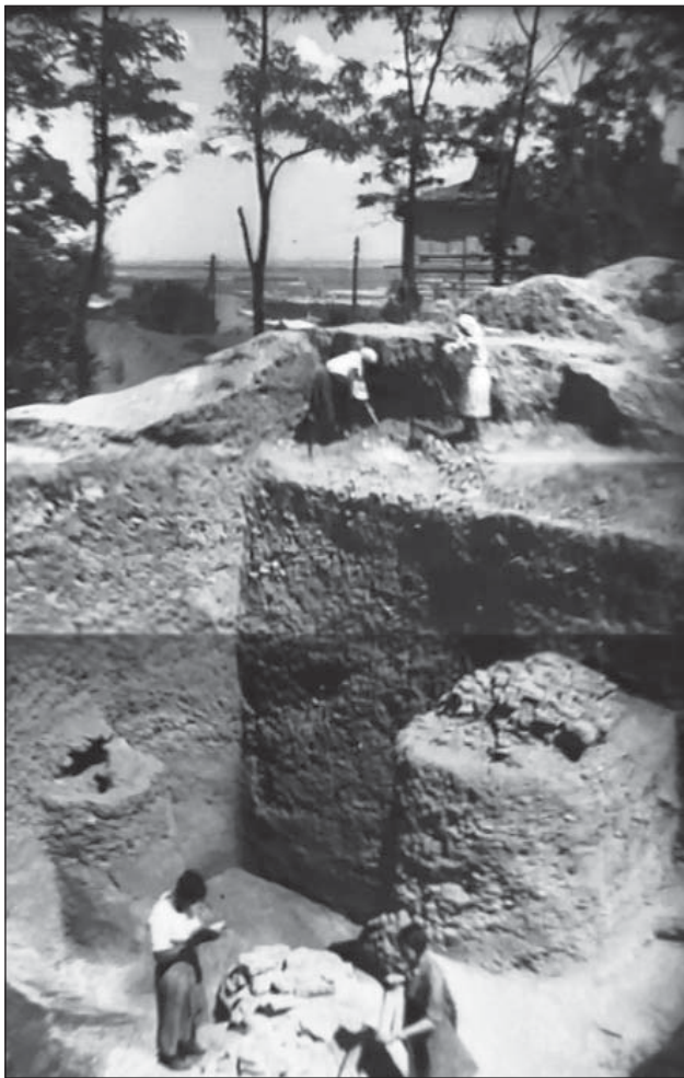
Іл. 2. Загальний вигляд ділянки 2 з південного заходу. Монтаж кадрів кінохроніки 1937 р. [ЦДКФФА, № 7151]
