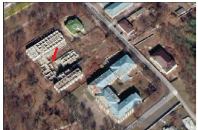
Іл. 4. Недобудова готельно-туристичного комплексу «Дворянське зібрання». Знімок 2019 р. з ресурсу Google maps. (стрілкою позначено місцезнаходження кам'яниці магістрату)
