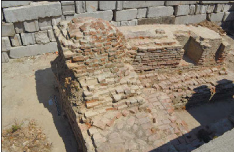
Іл. 9. Північний кут будівлі магістрату. Вигляд зі сходу. Світлина 2020 р.
