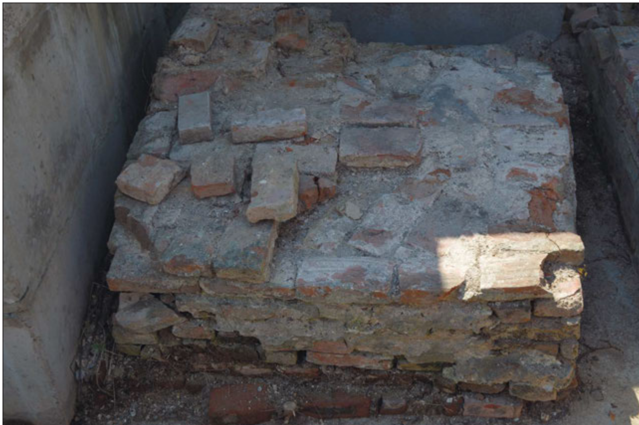
Іл. 12. Мурування опорного стовпа. Світлина 2020 р.
