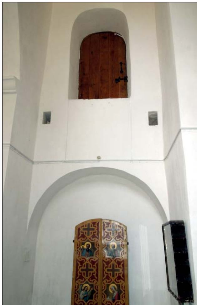
Іл. 16. Північна стіна нартексу. Вхід та гнізда балок хорів, ніша першого ярусу. Світлина 2013 р.
