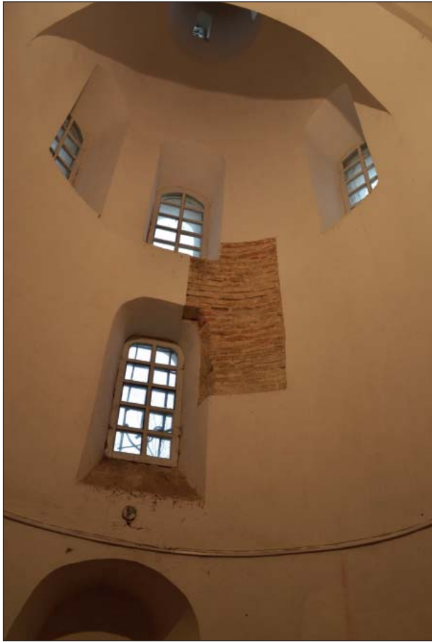
Іл. 13. Видгляд на апсиду з наосу. Розташування вікон та характер мурування в демонстраційному зондажі. Світлина 2016 р.
