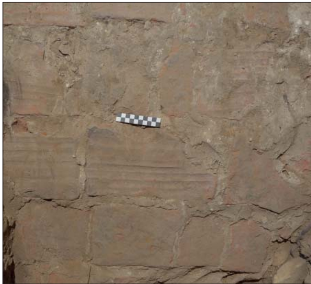
Іл. 9. Мурування склепіння переходу з Іллінської церкви до підземних приміщень. Світлина 2015 р.
