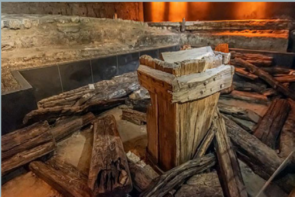
Фрагменти давніх дерев'яних конструкцій
