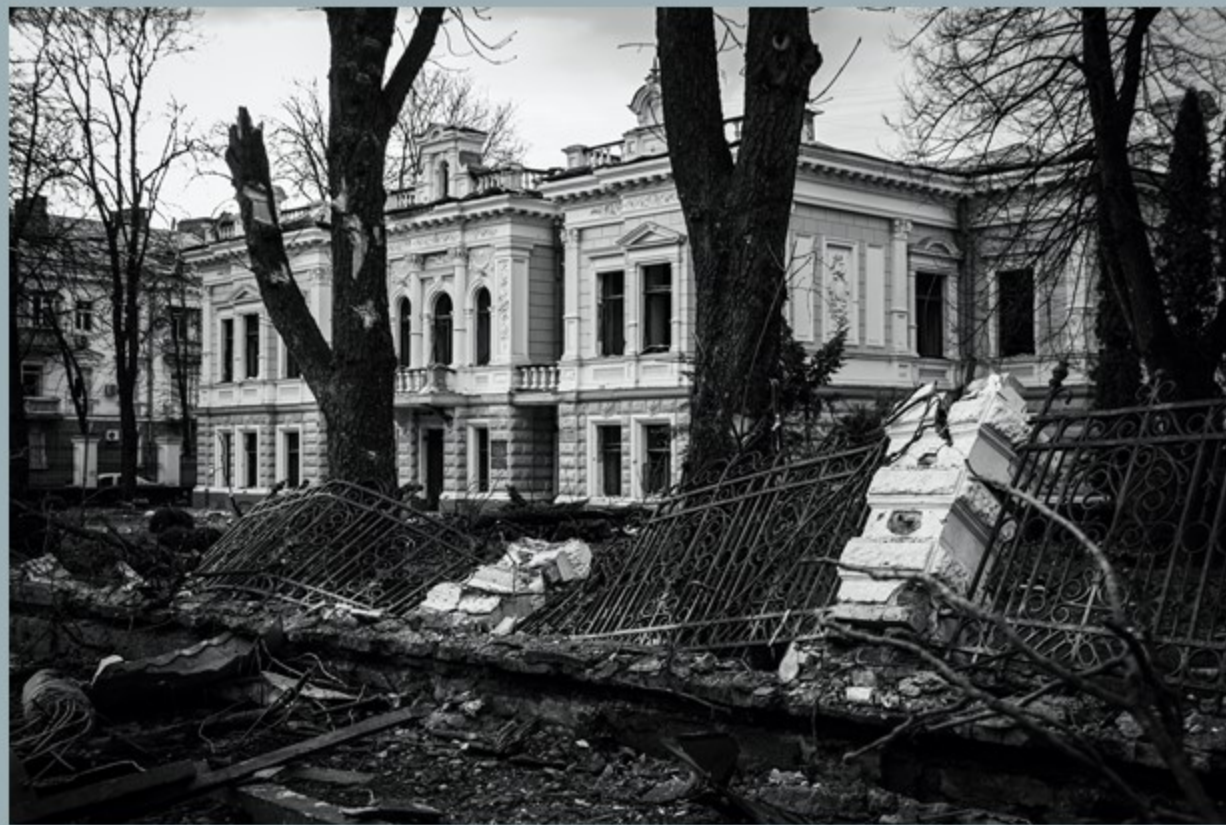
Огорожа садиби, Суми, вул. Петропавлівська, 54
