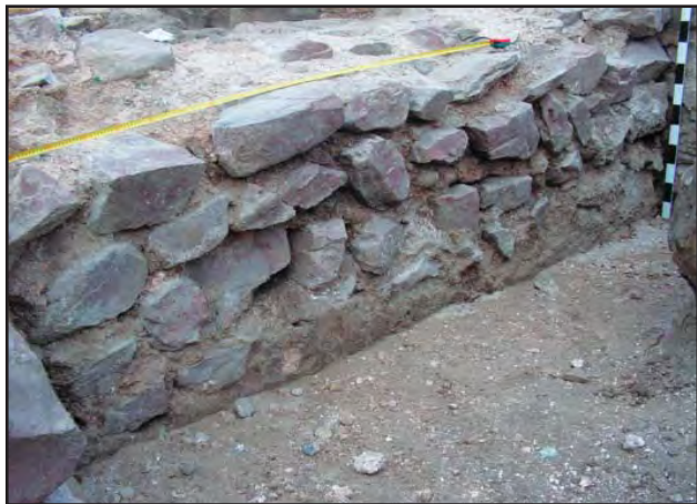
Іл. 5. Червоний кварцит у кладці фундаменту південної стіни Десятинної церкви. Фото А.А. Чекановського. 2005 р.
