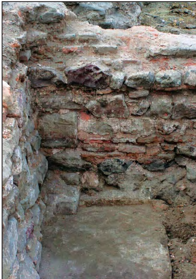
Іл. 13. Ділянка ремонту XII ст. південно-західного кута Десятинної церкви. Фото А.А. Чекановського. 2005 р.
