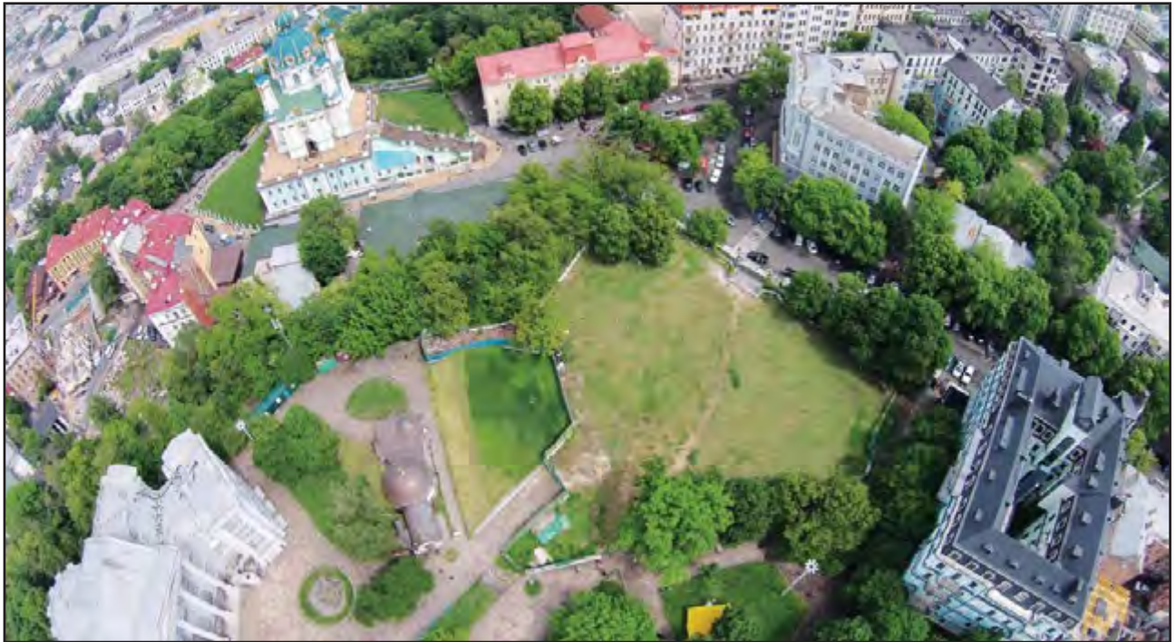
Іл. 3. Аерофотозйомка 2014 року законсервованих фундаментів Десятинної церкви
