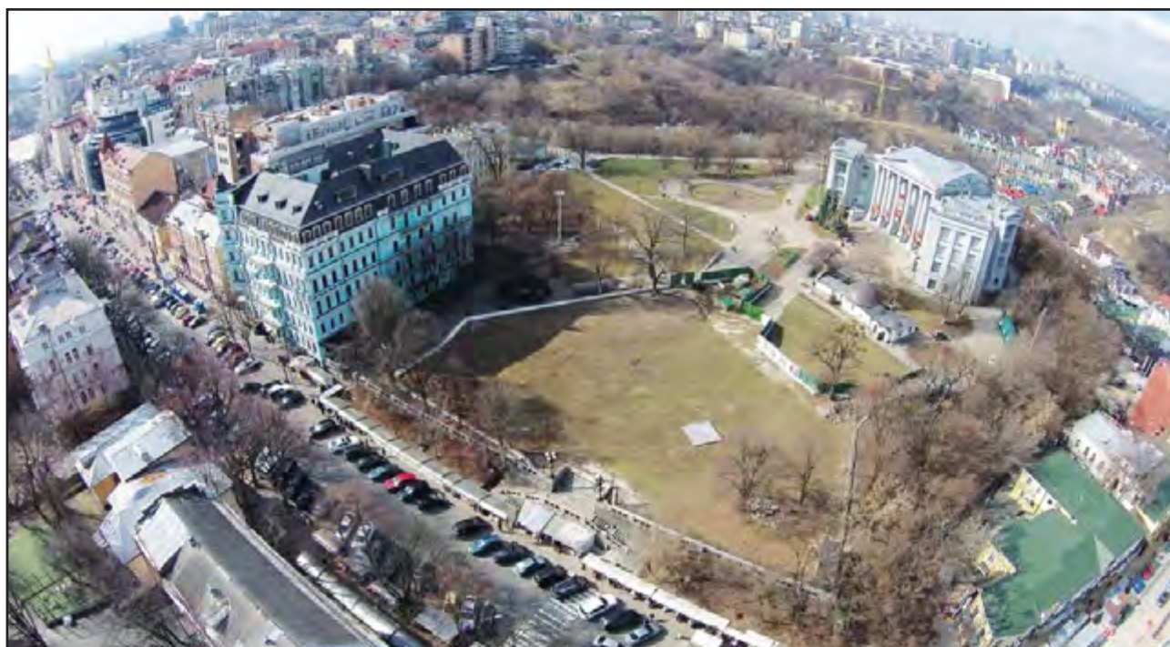
Іл. 4. Аерофотозйомка 2015 року законсервованих фундаментів Десятинної церкви
