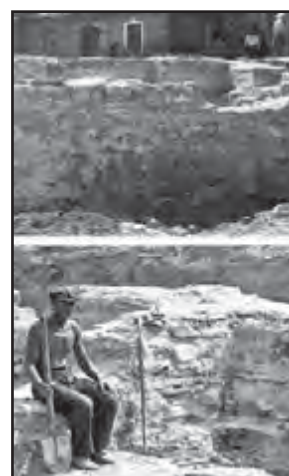
Іл. 16. Кладка opus mixtum ремонту XII ст. північної стіни південно-західного компартименту Десятинної церкви. Літо 1939 р. НА ІА НАН України, негатив № 8136 (фрагмент), № 8063 (фрагмент)
