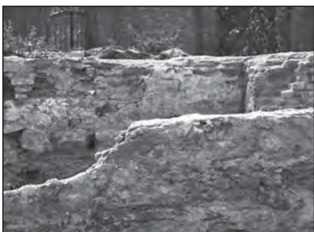
Іл. 13. Місце стику хрещатого стовпа (першого із заходу) кінця X ст. з кладкою південної стіни Десятинної церкви XVII ст. Літо 1939 р. НА ІА НАН України, негатив № 8136 (фрагмент)
