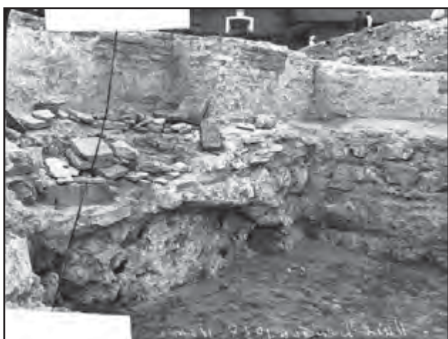
Іл. 15. Місце стику фундаменту кінця X ст. та ремонту першої третини XII ст. південної стіни Десятинної церкви біля її південно-західного кута. Літо 1938 р. НА ІА НАН України, негатив № 8060
