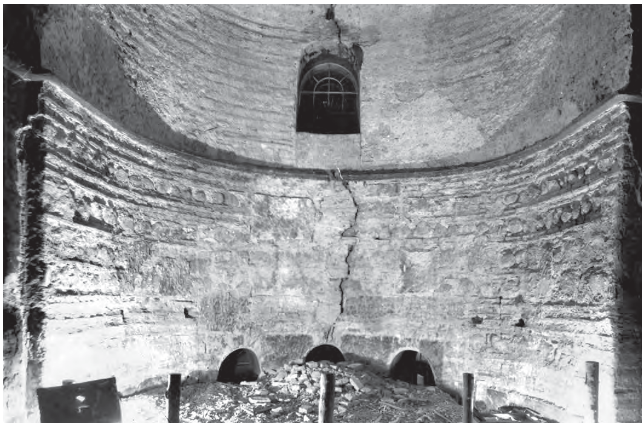
Іл. 6. Стіна апсиди Михайлівського Золотоверхого собору після демонтажу «Євхаристії» (у муруванні ліворуч і праворуч – отвори від колод риштування)
