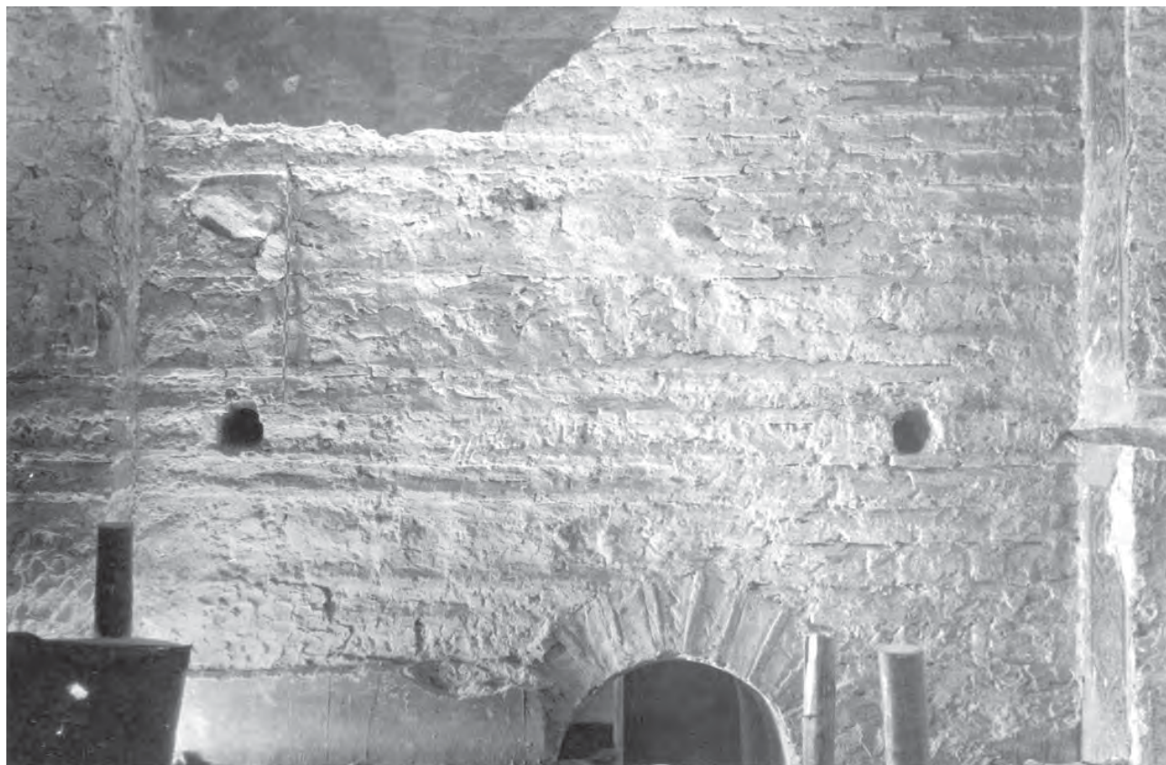
Іл. 8. Південна стіна віми Михайлівського Золотоверхого собору після демонтажу мозаїк (у муруванні – отвори від колод риштування)
