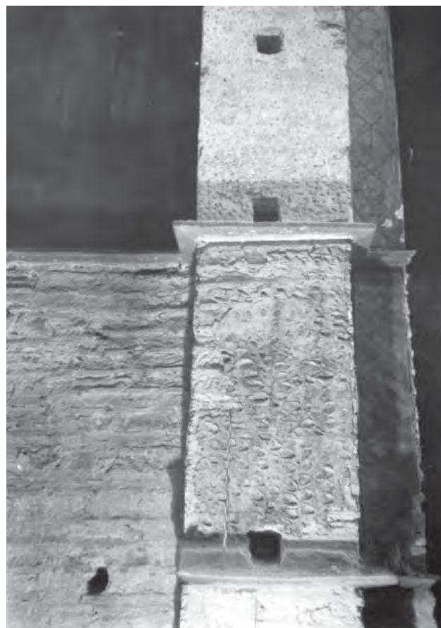
Іл. 10. Південна лопатка вівтарної арки та південна стіна віми Михайлівського Золотоверхого собору після демонтажу мозаїк з отворами від колод риштовання
