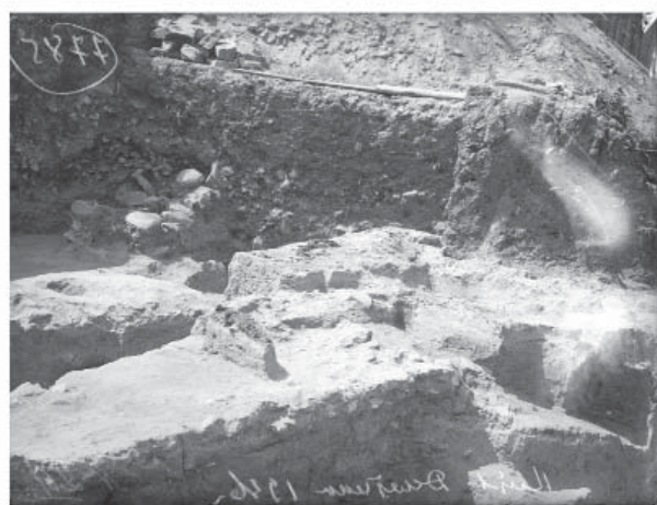
Іл. 8. Можливі залишки фундаменту «терему», відкритого 1907 р., з каналами субструкцій (1).
