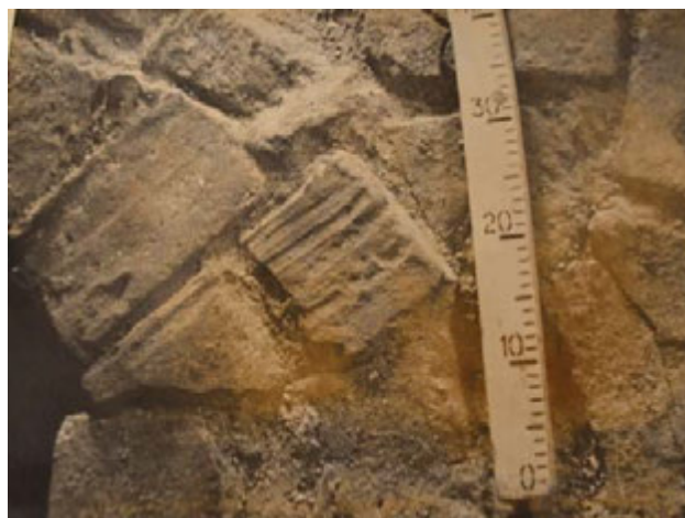
Іл. 11. Цегла-пальчатка в ремонтному муруванні апсиди Спасо-Преображенського собору. [За: В.П. Коваленком]
