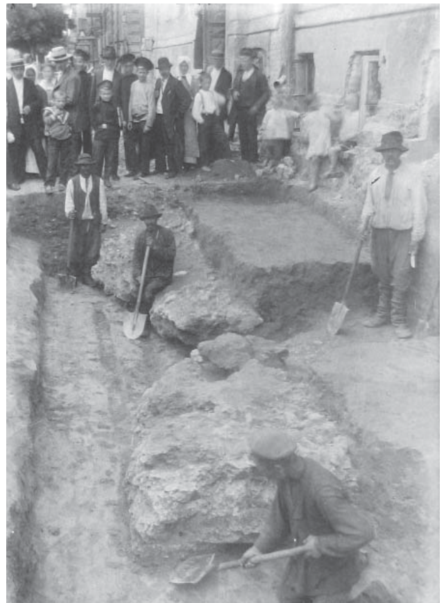
Іл. 8. Південно-східна споруда («Південний палац»). Фундаменти біля будинку по Володимирській, 4. Фото розкопок С. П. Вельміна 1914 р. ФО НА ІМК РАН (відб. О. 573.1)
